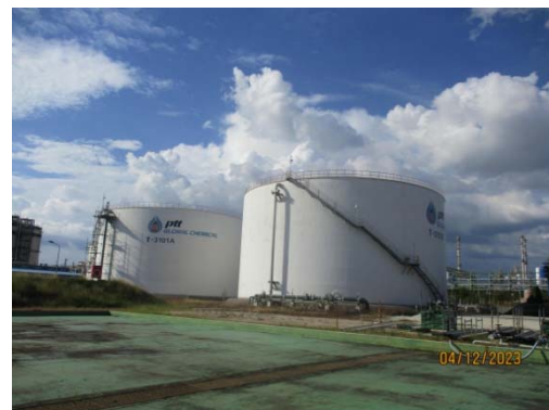
รูปที่ 56 ถังสำรองน้ำดับเพลิง
