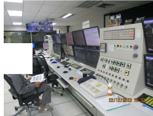
รูปที่ 60 ระบบ Distributed Control System (DCS) ควบคุมต่างๆ
