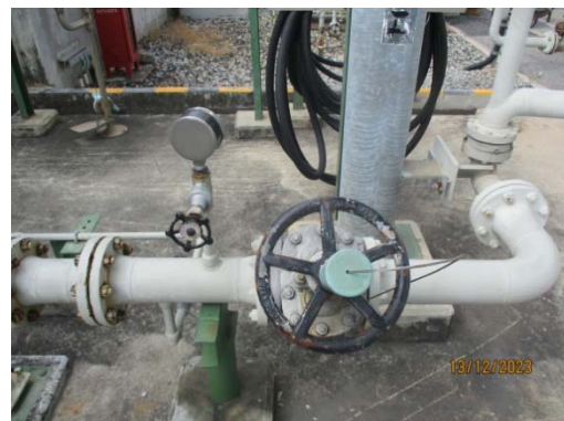
รูปที่ 74 Shut off Valve
