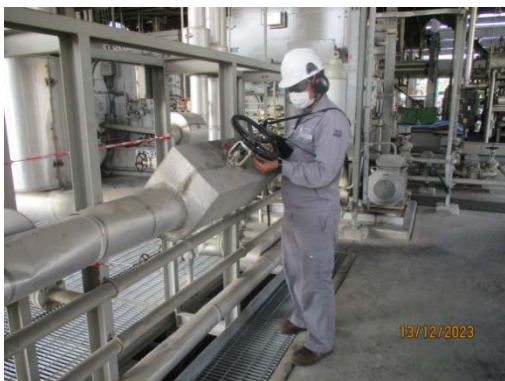
รูปที่ 39 การตรวจสอบการรั่วไหลของสารเคมี
