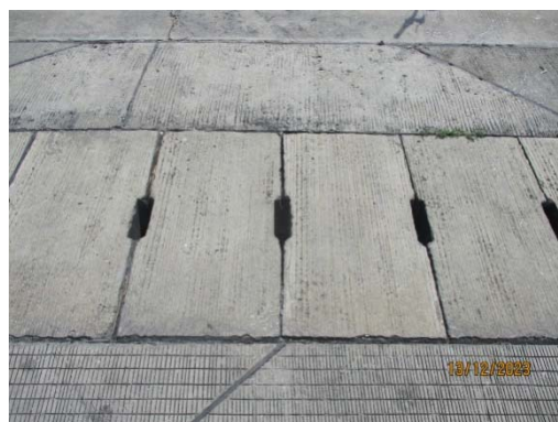
รูปที่ 22 รางระบายน้ำที่มีตะแกรงปิดสำหรับรองรับน้ำที่ใช้ทำความสะอาดพื้นที่อาคารเก็บวัสดุ
