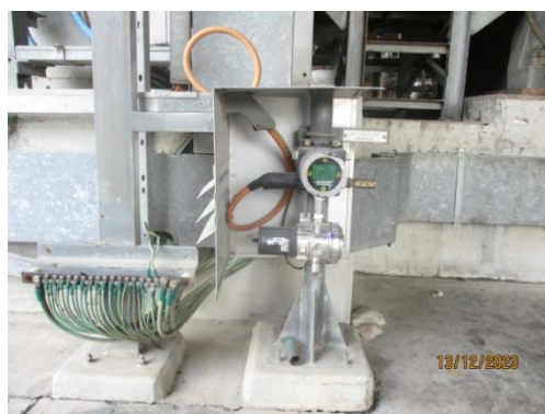
รูปที่ 52 Gas Detector
