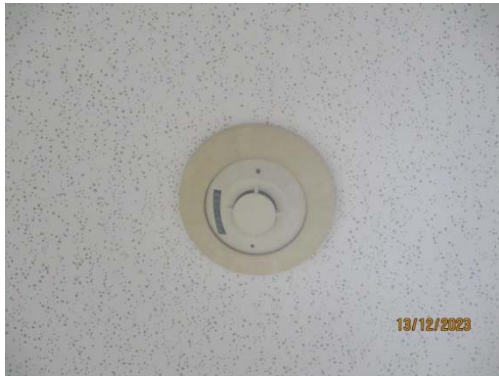
รูปที่ 53 Smoke Detector
