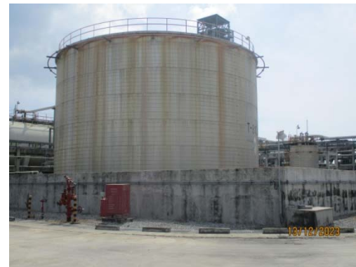
รูปที่ 40 คันคอนกรีตรอบถังเก็บสารเคมี
